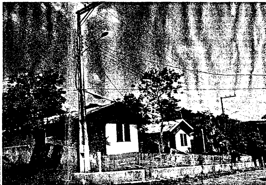
Abandonada há três meses, a vila construída na reserva indígena de Tamarana virou alvo de vandalismo
