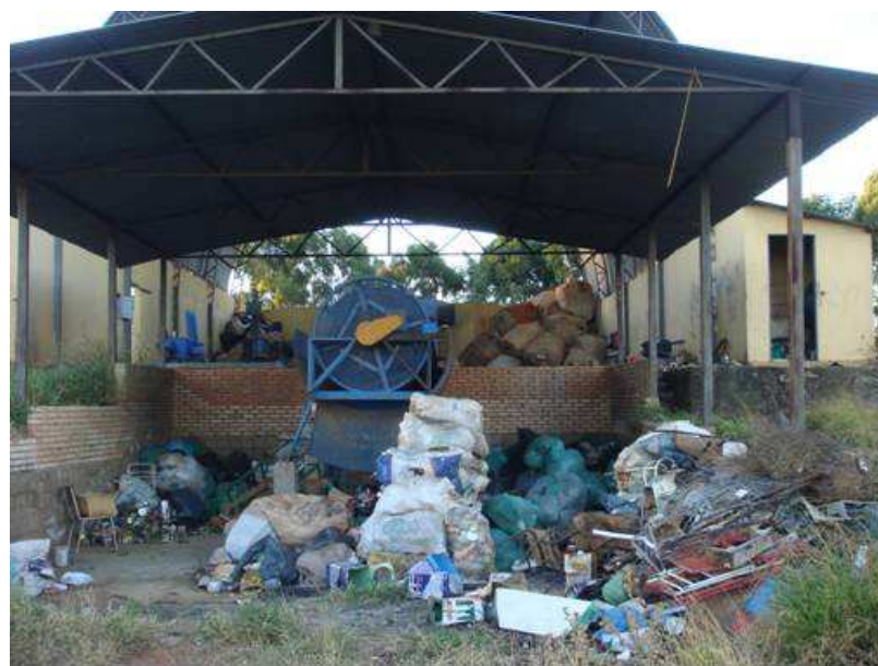
Figura 106 - Usina de Reciclagem desativada no município de Alto Paraíso de Goiás
