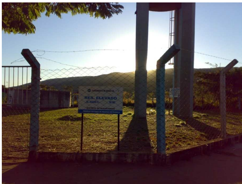
Figura 92 - Reservatório de Água Tratada no Município de Niquelândia
