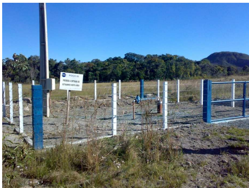
Figura 95 - Poço Artesiano 2 (Coordenadas UTM - 225631 E; 8435998 N; Zona: 23 L)
