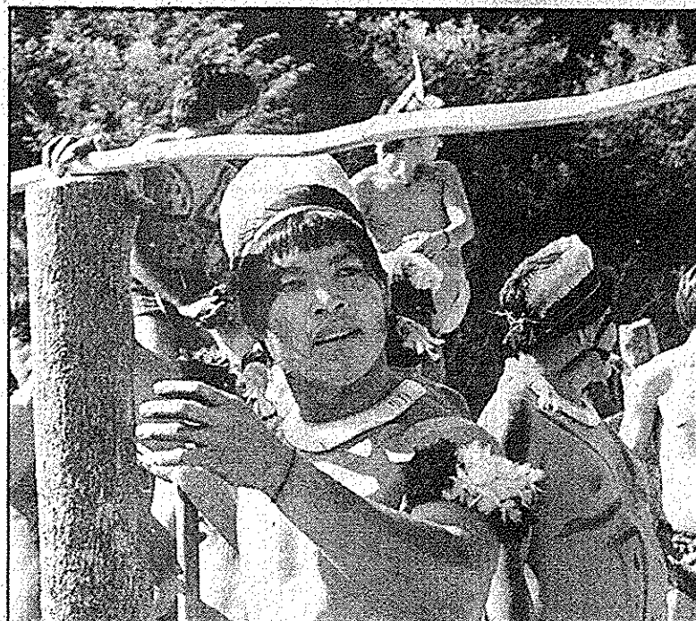
Índios trabalham na construção da aldeia Kari-Oca, em Jacarepaguá
