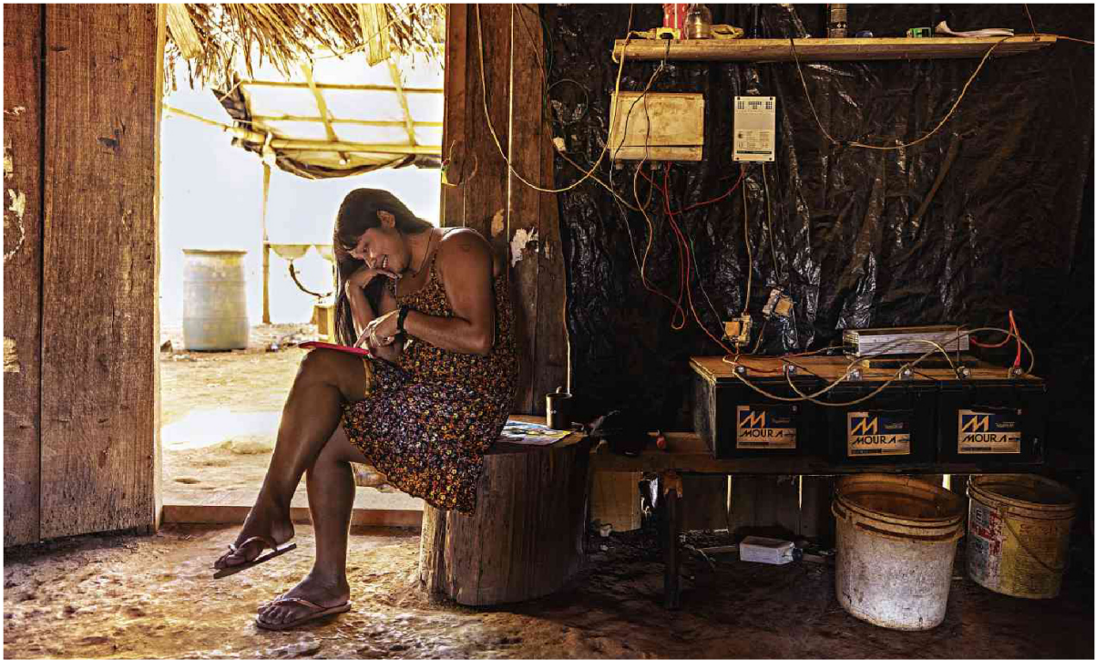
Kamihukalu Kamayura, 31, usa o celular ao lado das baterias que são abastecidas por placas solares, em sua casa na aldeia Ngosoko, na Terra Indígena Wawi, no Xingu. Fotos Lalo de Almeida/Folhapress
