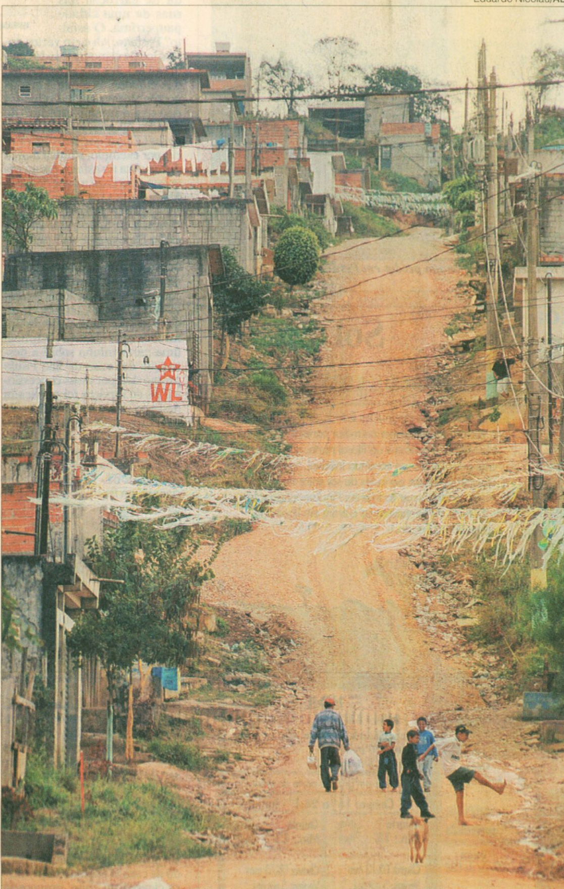
Jardim Novo Horizonte, que começou há dez anos às margens da Represa Billings: casas ganham segundo andar, às vezes até um terceiro, para abrigar as famílias
