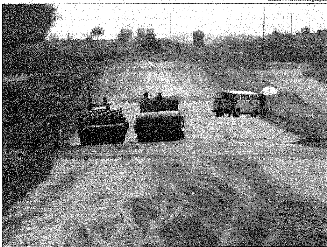
Rodovia no Mato Grosso, que será pavimentada pelo programa de consórcios rodoviários do Estado
