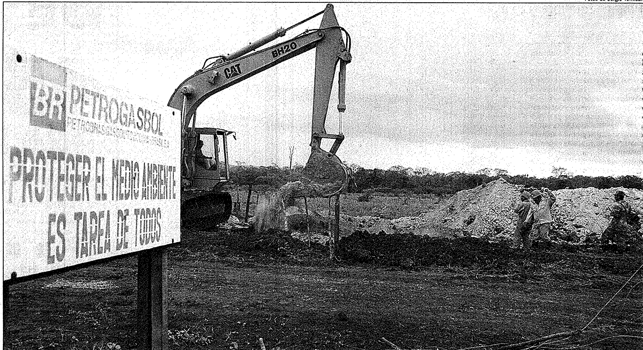
CANTEIRO DE OBRAS DO Gasoduto Brasil-Bolívia: ambientalistas temem sérios danos ao ecossistema do Pantanal mato-grossense com o uso de cargas de explosivos para remoção de rochas
