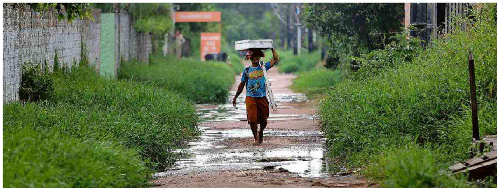
Conjunto habitacional Tauari, em Ananindeua, sofre constantes alagamentos após chover, quando os canais de esgoto invadem as casas. Pedro Ladeira/Folhapress
