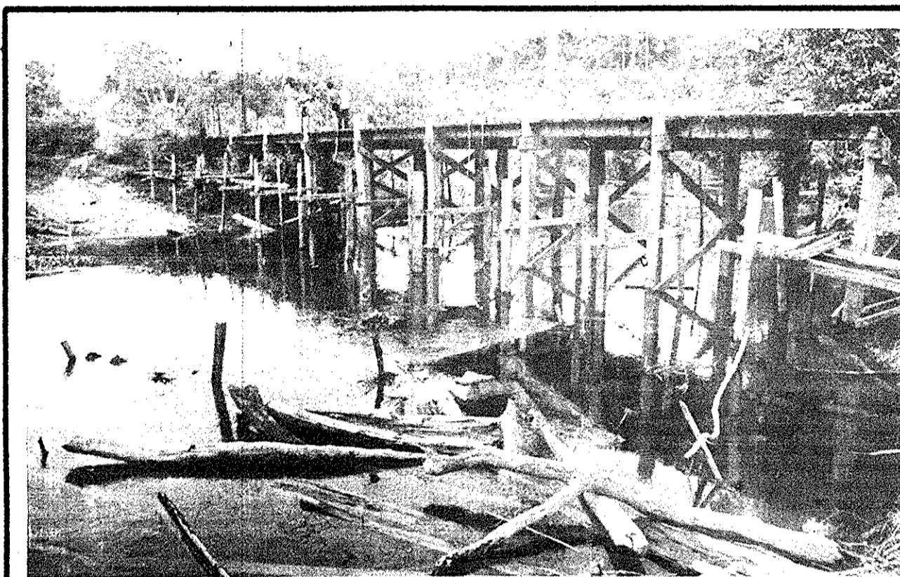
A ponte de 18 metros, queimada nas extremidades, já foi recuperada
