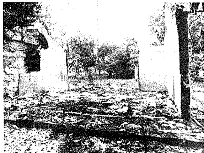
Só restaram as paredes desta casa na área de Meger
