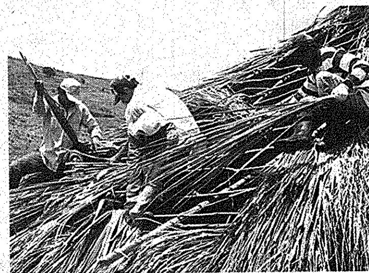
No alto e acima, os mocambos em construção na Vila dos Palmares
