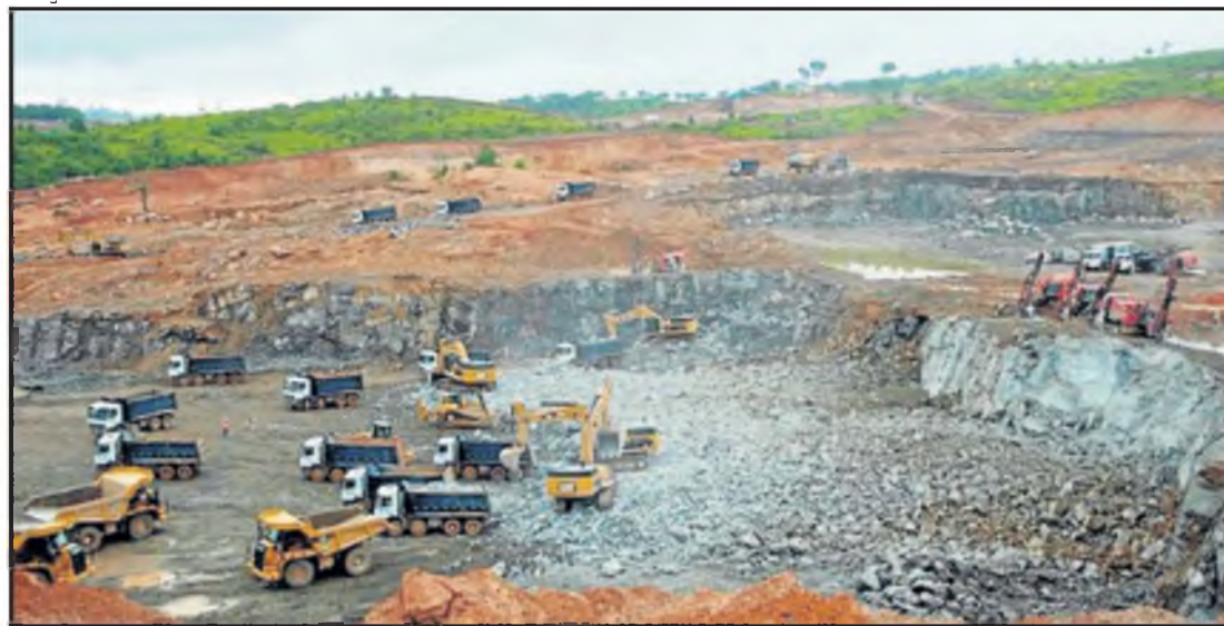
Caminhões preparavam o terreno, mas a Secretaria de Meio Ambiente do Governo do Pará suspendeu a obra
