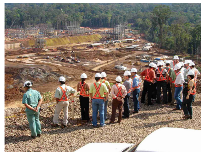
Obras da mineradora MMX em Serra do Navio (AP)
