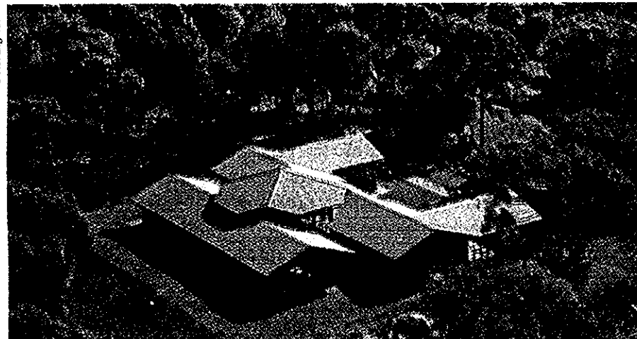
Vista aérea do Centro de Cultural Kaingang em Mangueirinha no Paraná.
