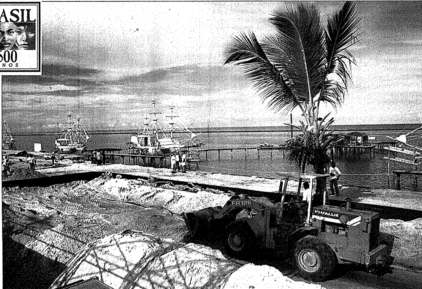
Obras para a festa dos 500 anos estão inconclusas; o cais onde as caravelas ficarão ancoradas e as embarcações ainda estão em obras
