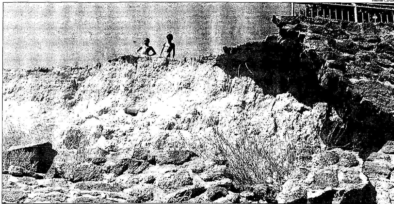
Proteção de pedra e concreto em frente a aldeia dos índios carajás, em Aruanã, foi carcomida pela água do canal. Prefeitura pediu recursos em Brasília para contenção do barranco
