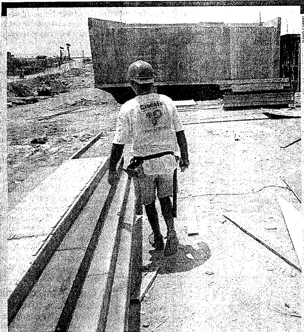
■ Operário Antonio Barroso de Oliveira no canteiro de obras da estrada em Caucaia
