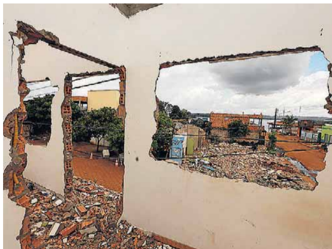
Entulho. Casa recém-derrubada pela Norte Energia
