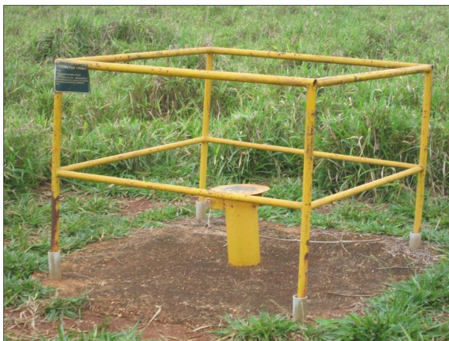
Figura 1 - Piezômetro localizado no entorno da APE.
