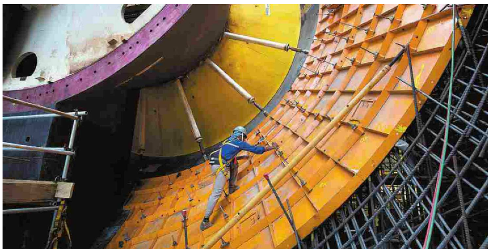
Operários trabalham na instalação de turbina na barragem do sítio Pimental, na hidrelétrica de Belo Monte, rio Xingu
