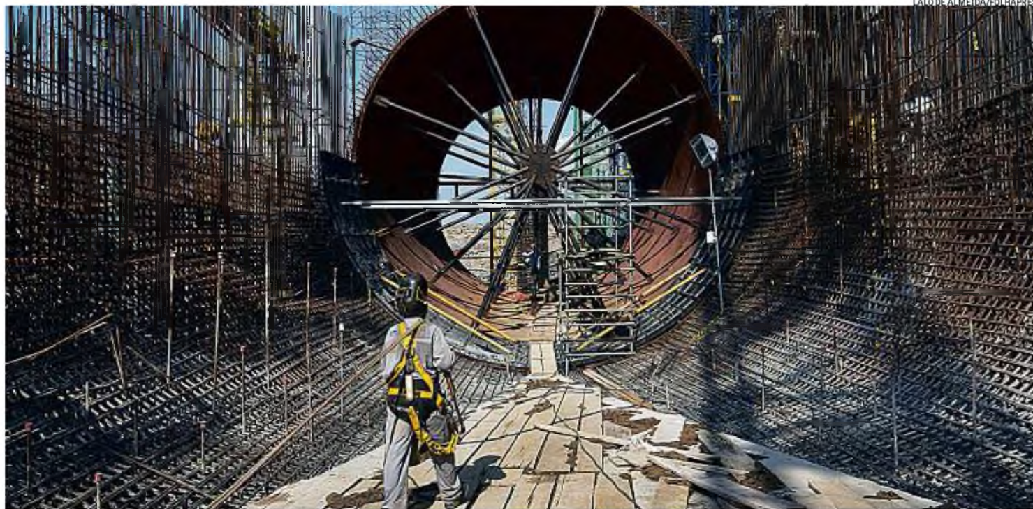
Operários trabalham na montagem da estrutura da hidrelétrica que irá abrigar turbina da casa de força no sítio Pimental, no rio Xingu, em Altamira, no Pará
