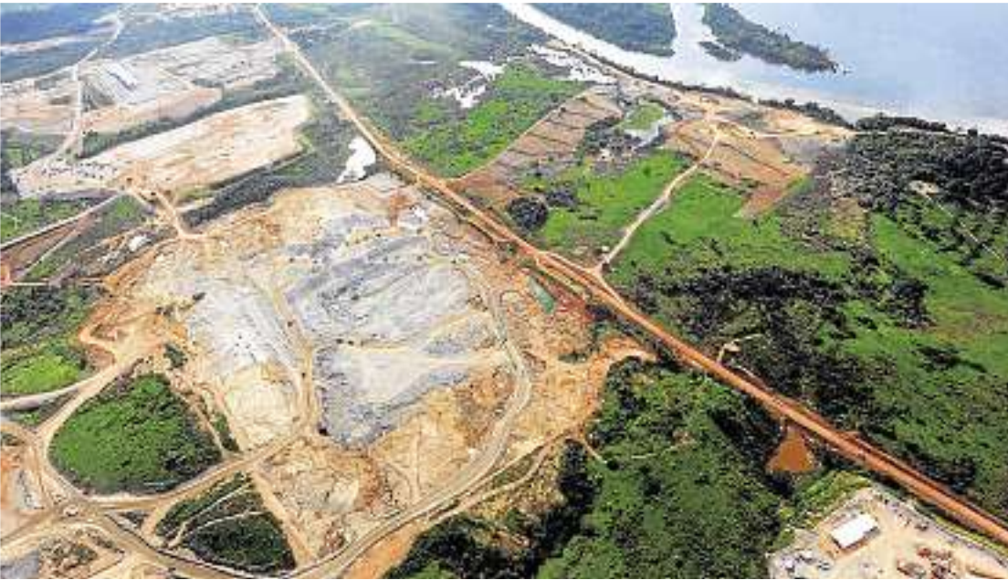
Vista aérea. Usina Hidrelétrica de Belo Monte, erguida na Amazônia, enfrenta a resistência de ambientalistas
