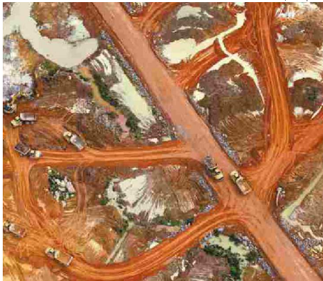
Máquinas trabalham em canal da usina de Belo Monte
