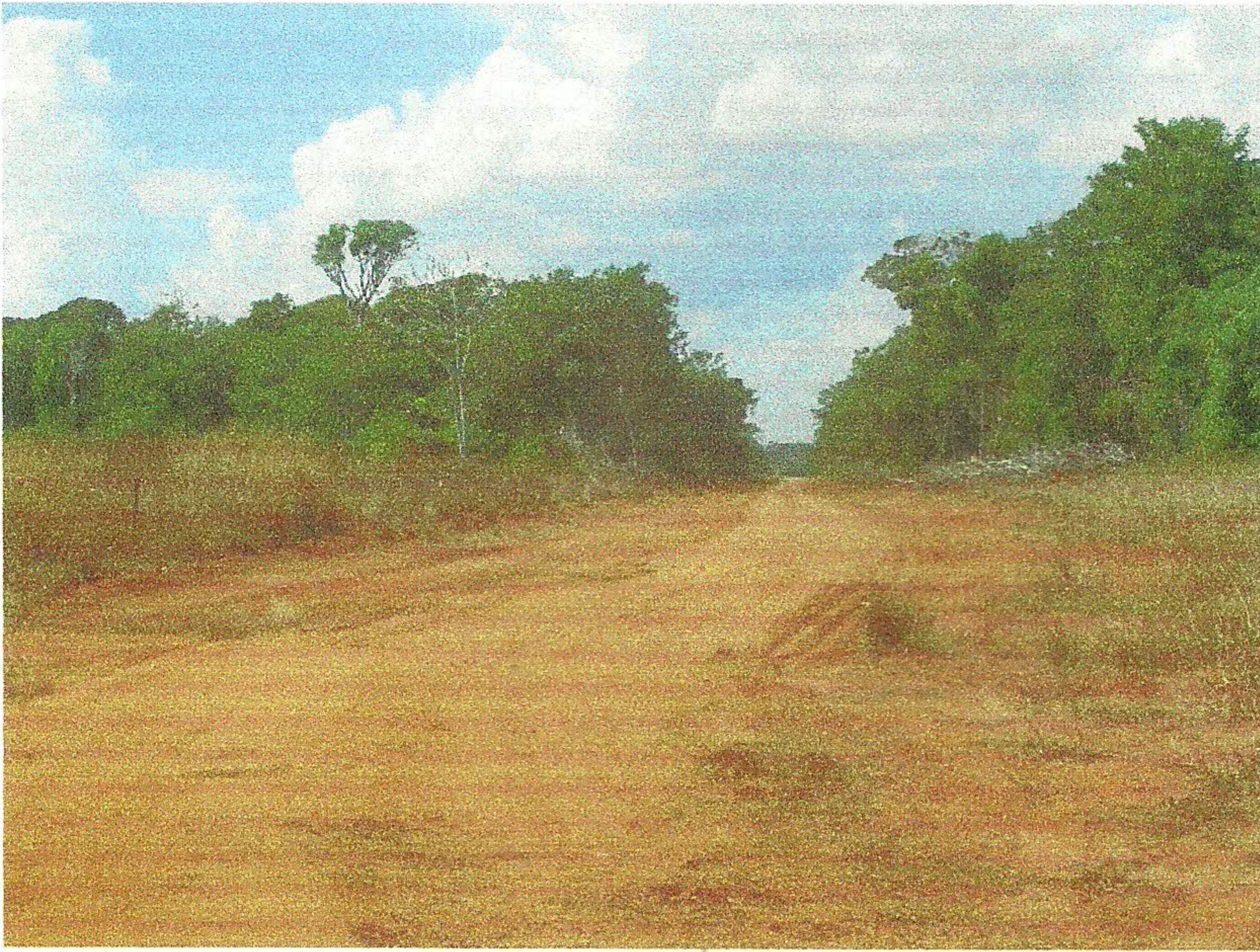
Estrada aberta para Nova Maringá, acesso à ponte reconstruída.
