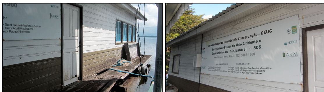
Figuras 6 e 7 - Base fluvial de apoio às UCs estaduais do Rio Negro, inaugurada em 2011, está fechada.
