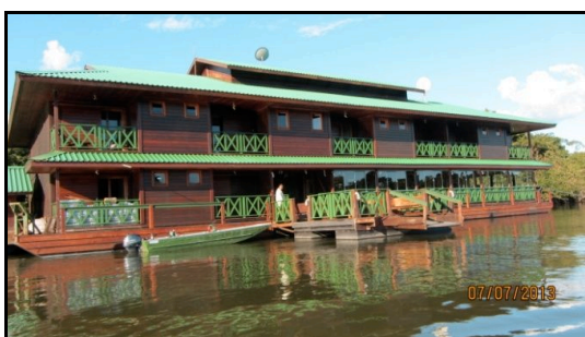
Figura 16 - Empreendimento turístico no Entorno da RDS Bararati
