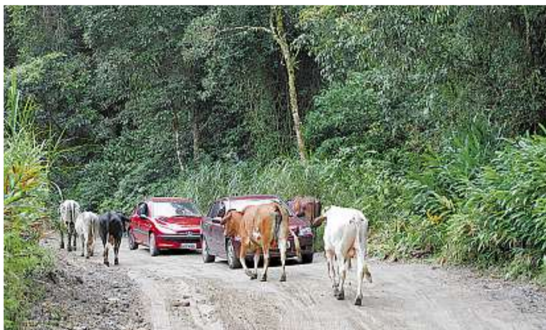
Descendo a serra. Estrada Paraty-Cunha, em estado precário de conservação, começou a ser pavimentada em maio
