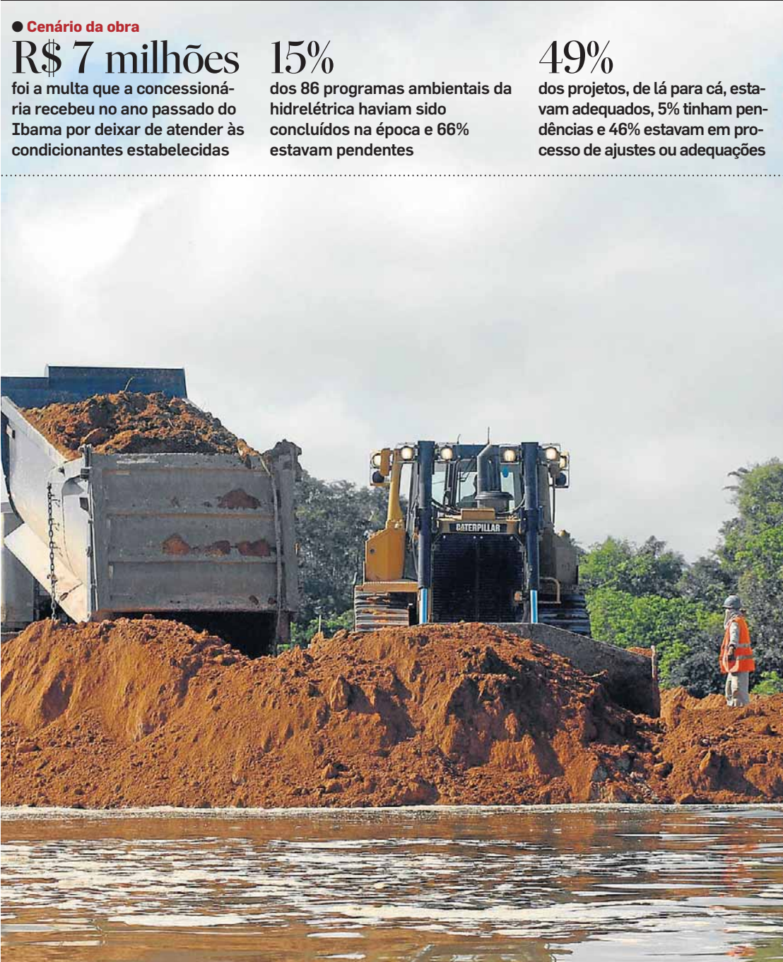
Obra polêmica. Desde o início, a Usina Belo Monte teve 15 invasões e 16 dias de greve
