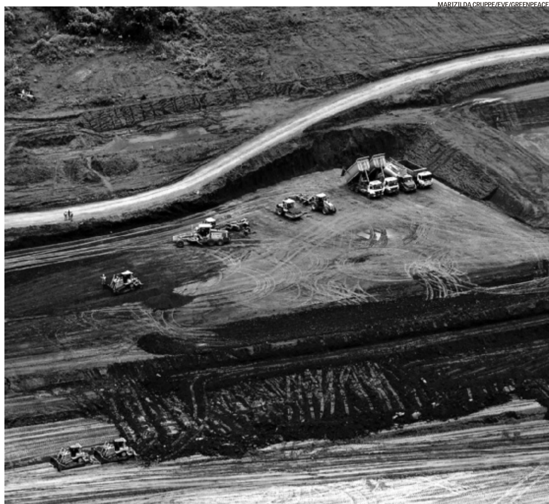
Mudança para o canteiro de obras vai acabar com a hora extra paga pelo deslocamento diário dos trabalhadores
