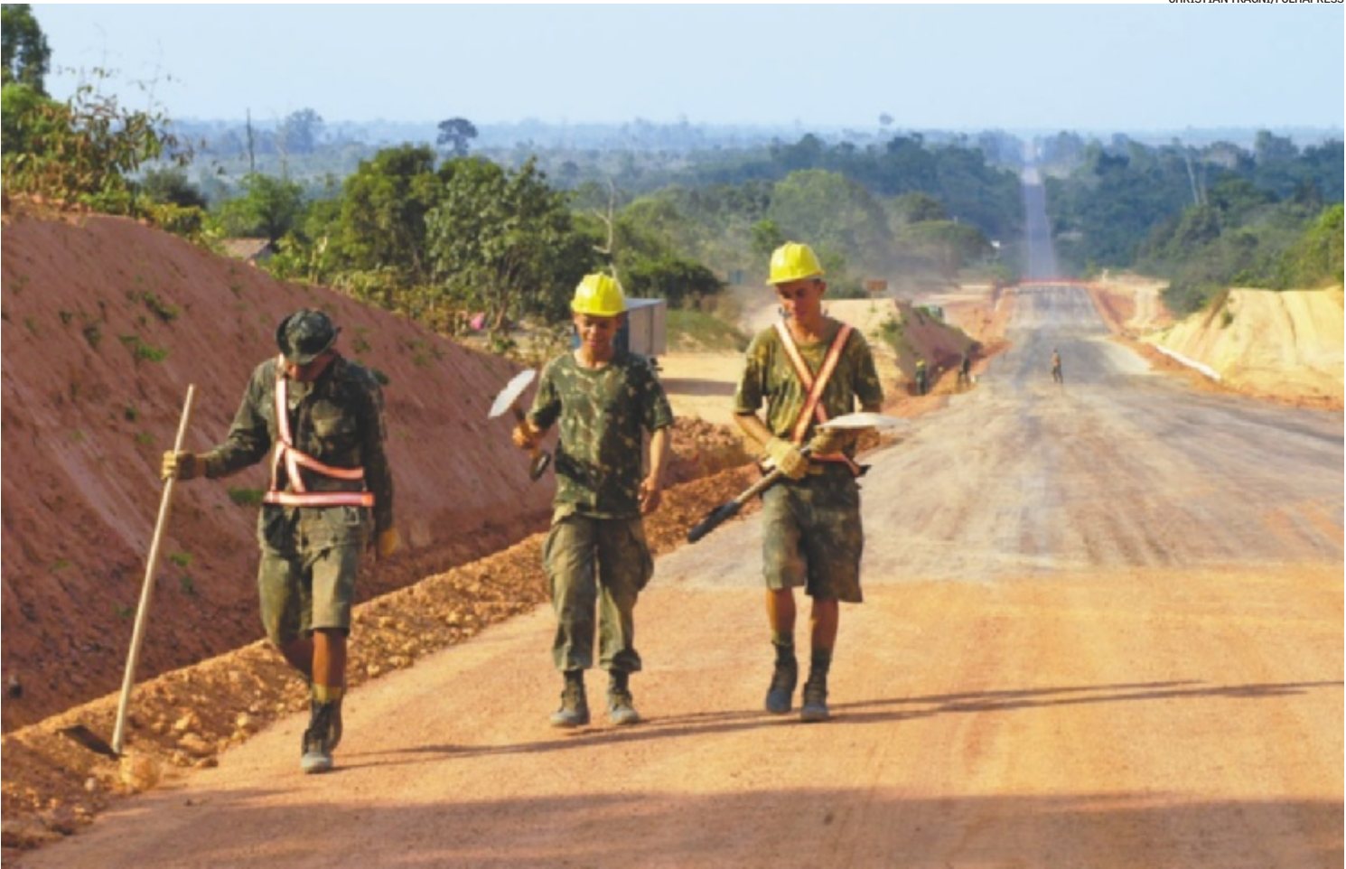
Obras na BR-163 avançam rumo à cidade paraense de Itaituba. Novo corredor de exportação será capaz de escoar até 20 milhões de toneladas de grãos
