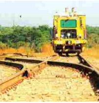
Obras na ferrovia Norte-Sul
