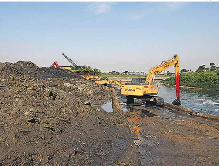
Ação. Canteiro de obras perto do Parque Ecológico do Tietê
