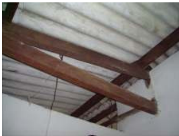
Detalhes do acabamento
