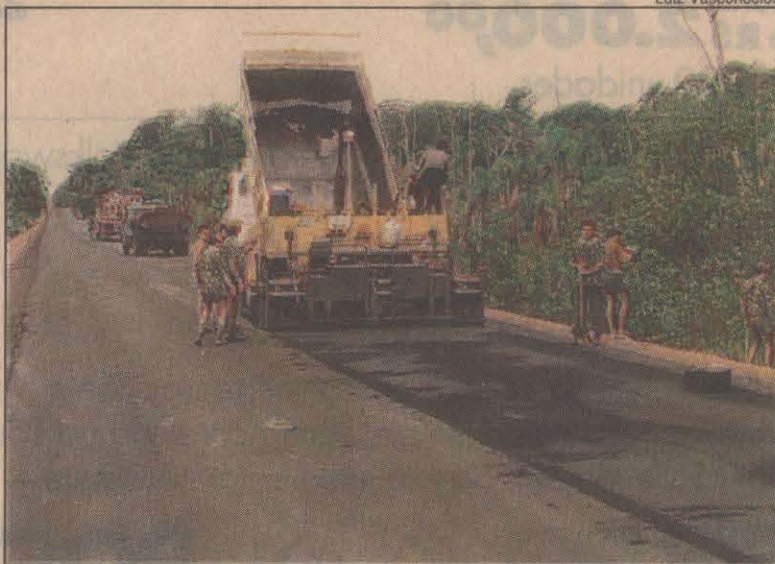
Os militares do 6º BEC têm asfaltado 800 metros por dia
