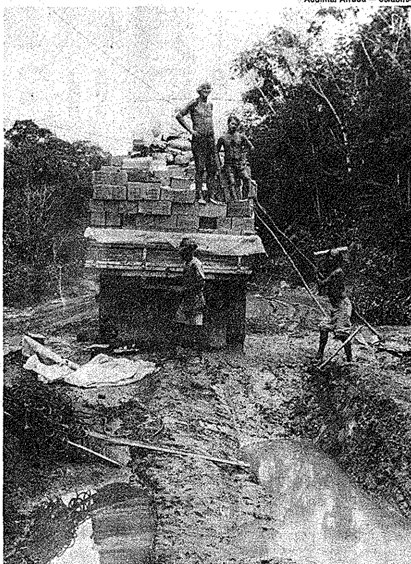
A estrada continua interditada por causa dos atoleiros no km 251
