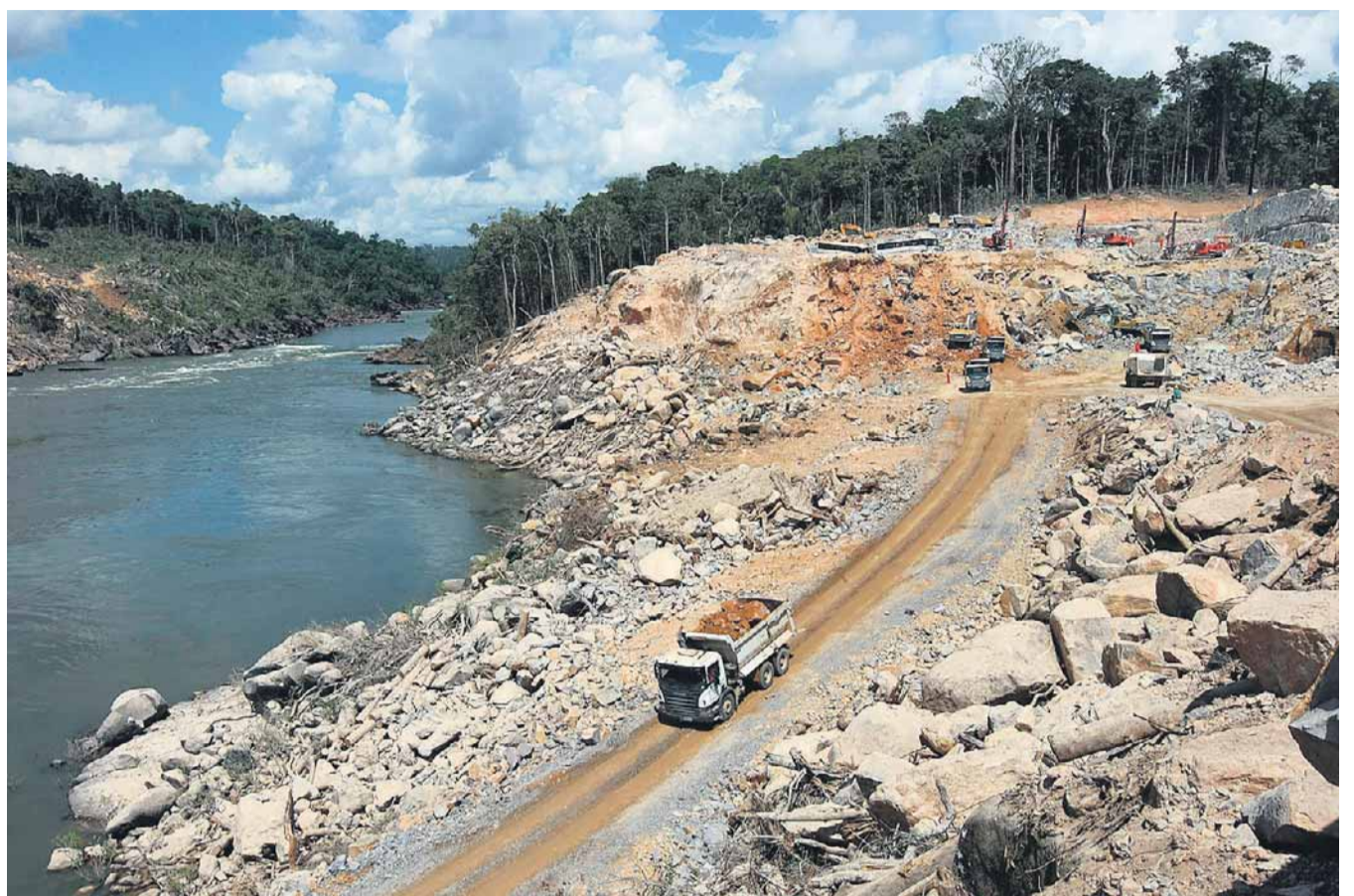
Novo cenário. Canteiro da usina de Teles Pires: índios exigem demarcação de reserva e ameaçam parar as obras
