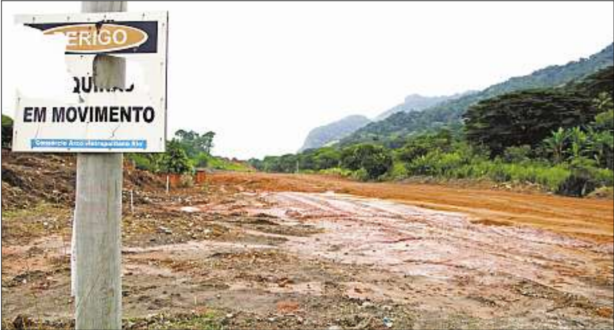
OBRAS DO Arco Rodoviário paradas em Brissamar, Itaguaí: conclusão era prevista para 2010, mas mudou para 2014
