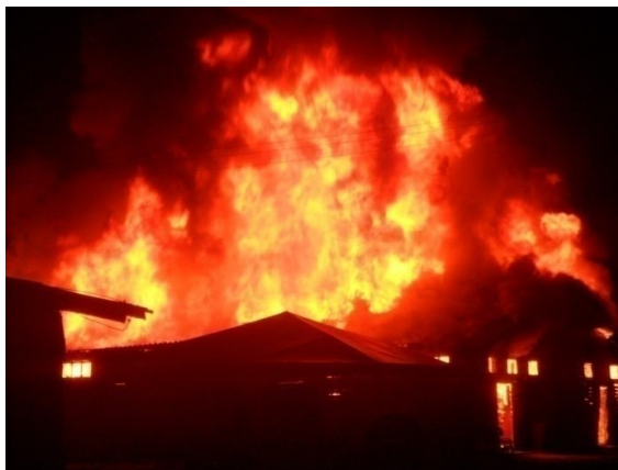
Foto 1 - Alojamento incendiado em 15/03/2011
