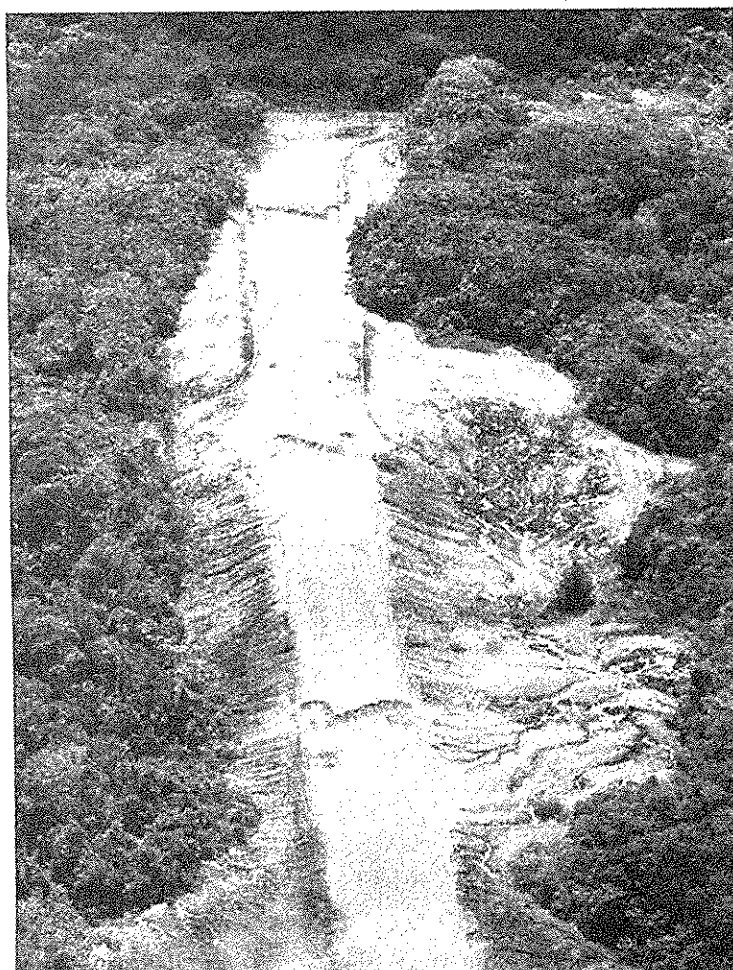
PROBLEMAS Apesar das dificuldades o trabalho foi concluído
