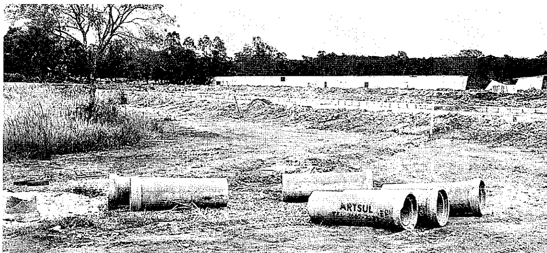
A blitz impediu a construção de um condomínio que estava sendo erguido na Ilha de Guaratiba
