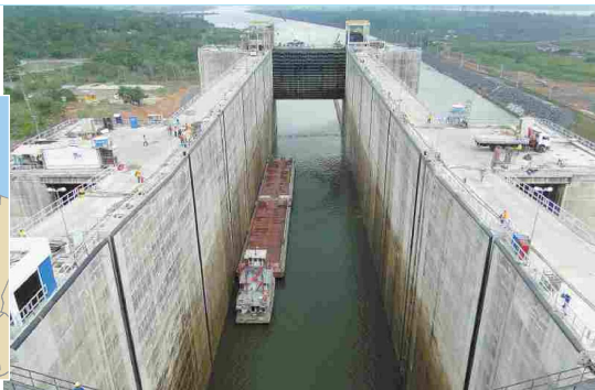
Eclusa de Tucuruí, que irá transportar grãos e minérios pela hidrovia de Tocantins
