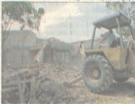
Demolição: 60% da obra estava concluída
