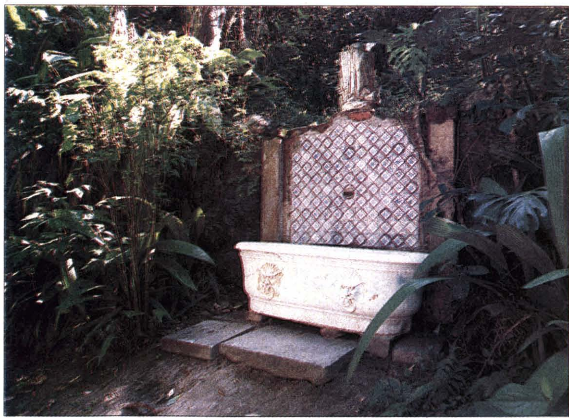
Localizadas na Fazenda do Visconde de Asseca, a bica e a banheira deverão ser restauradas
