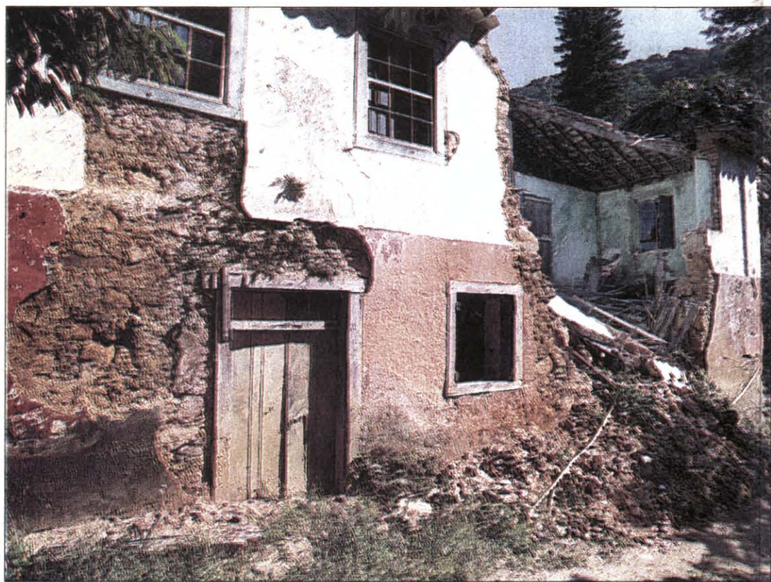
O casarão da antiga fazenda do Visconde de Asseca será reformado e transformado em museu
