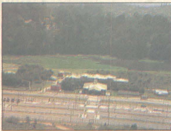
Vista aérea do parque: proteção aos mananciais
