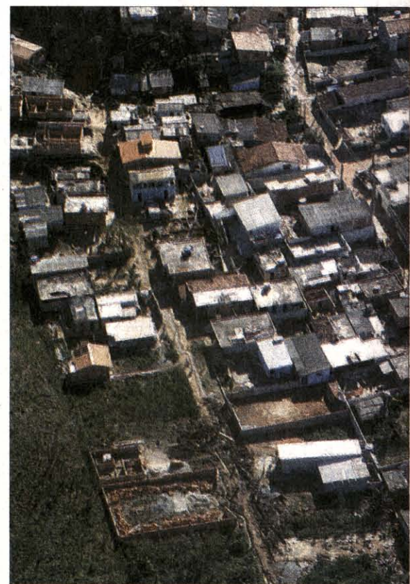
Duas das casas que foram demolidas na Vila Baiana
