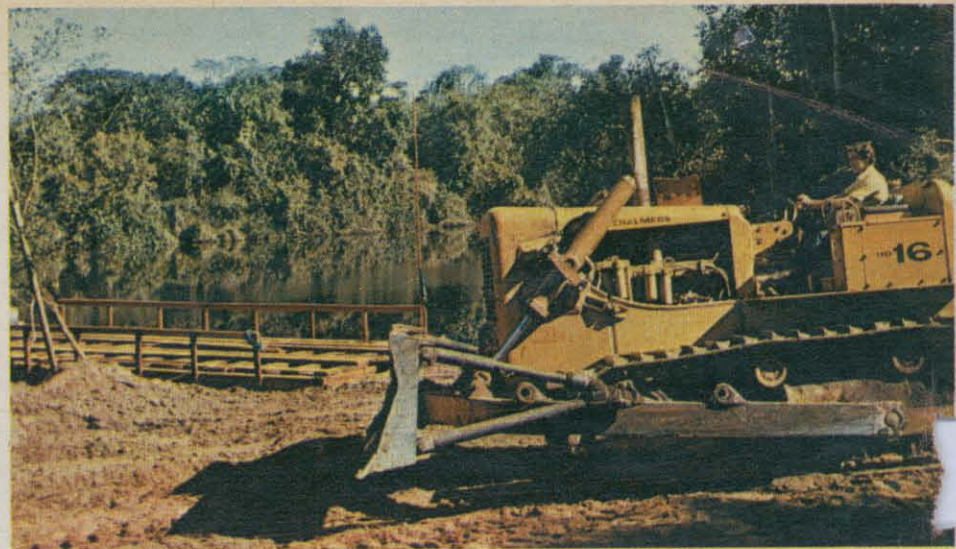
As máquinas de desmatamento limpam o futuro leito da estrada.
