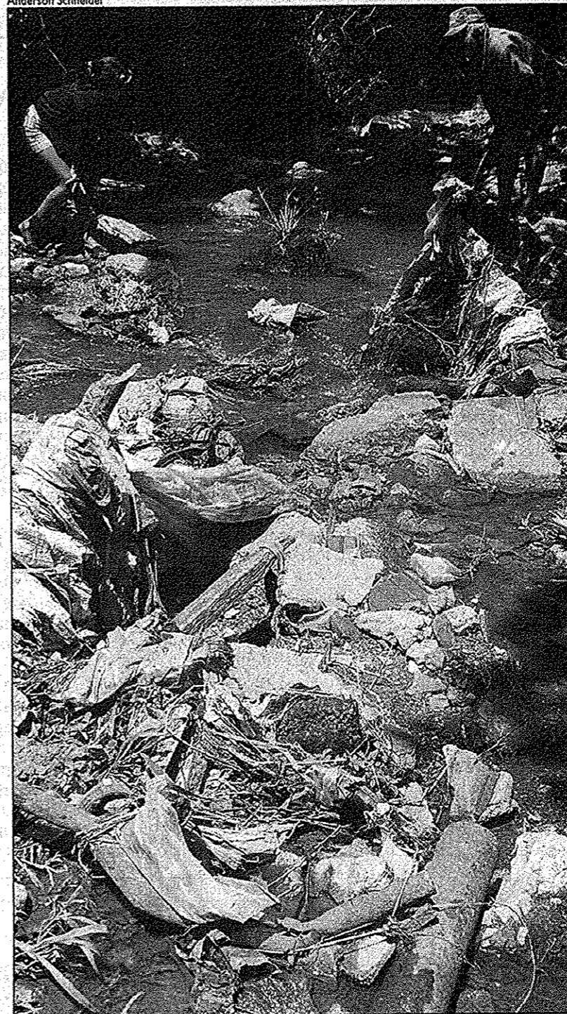
Córrego Cortado recebe dejetos provenientes de ligações clandestinas de esgoto
