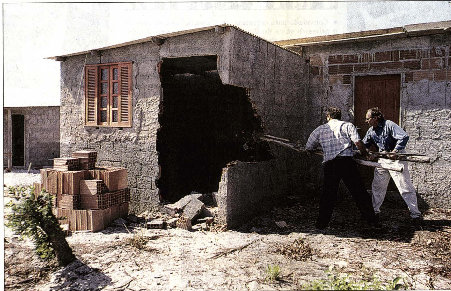
O DELEGADO Ícaro Silva (à esquerda) e o deputado Carlos Minc derrubam uma casa construída irregularmente na Restinga de Massambaba
