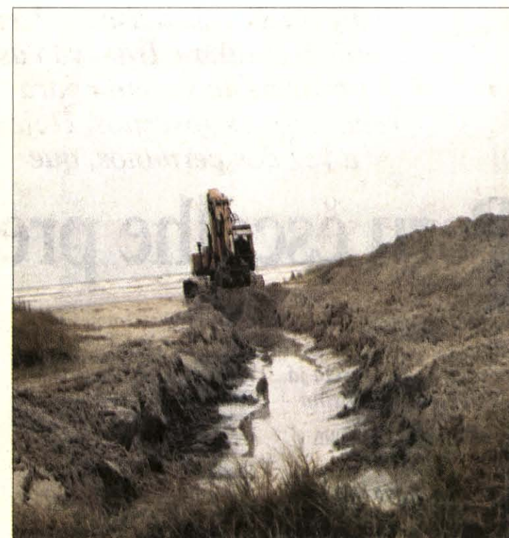
Prefeitura abre valas para evitar que o mar inunde a avenida
