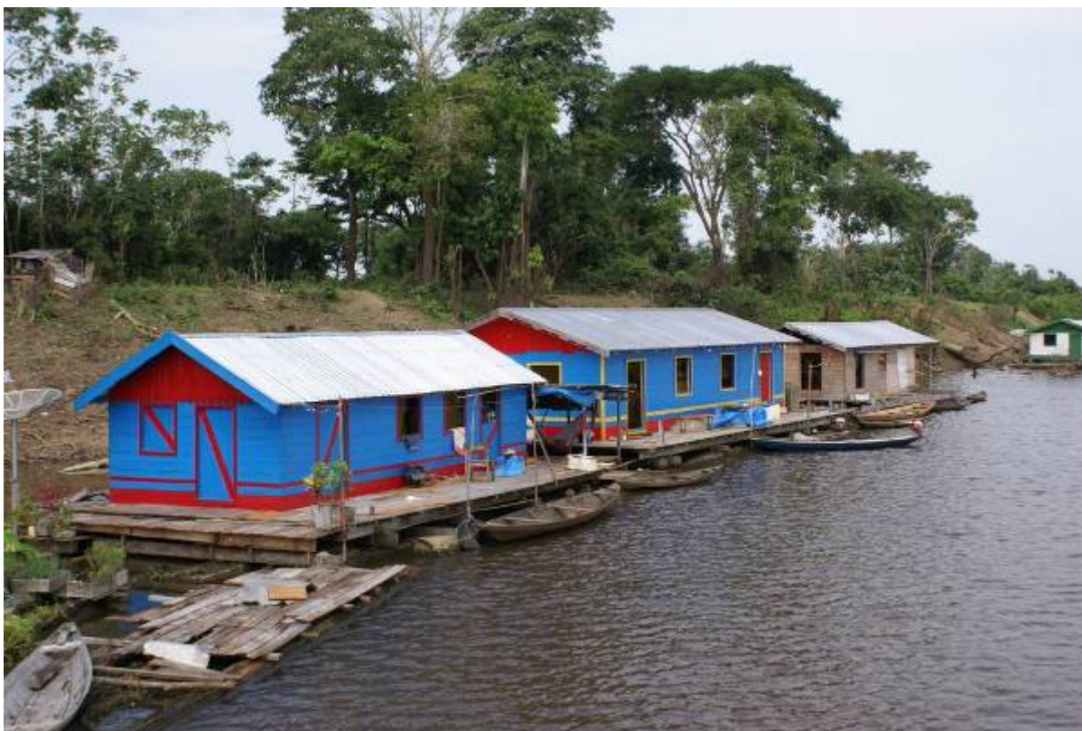
Figura 7.1.12. Comunidade “flutuante” Caua, localizada na zona norte da RDS-PP.
