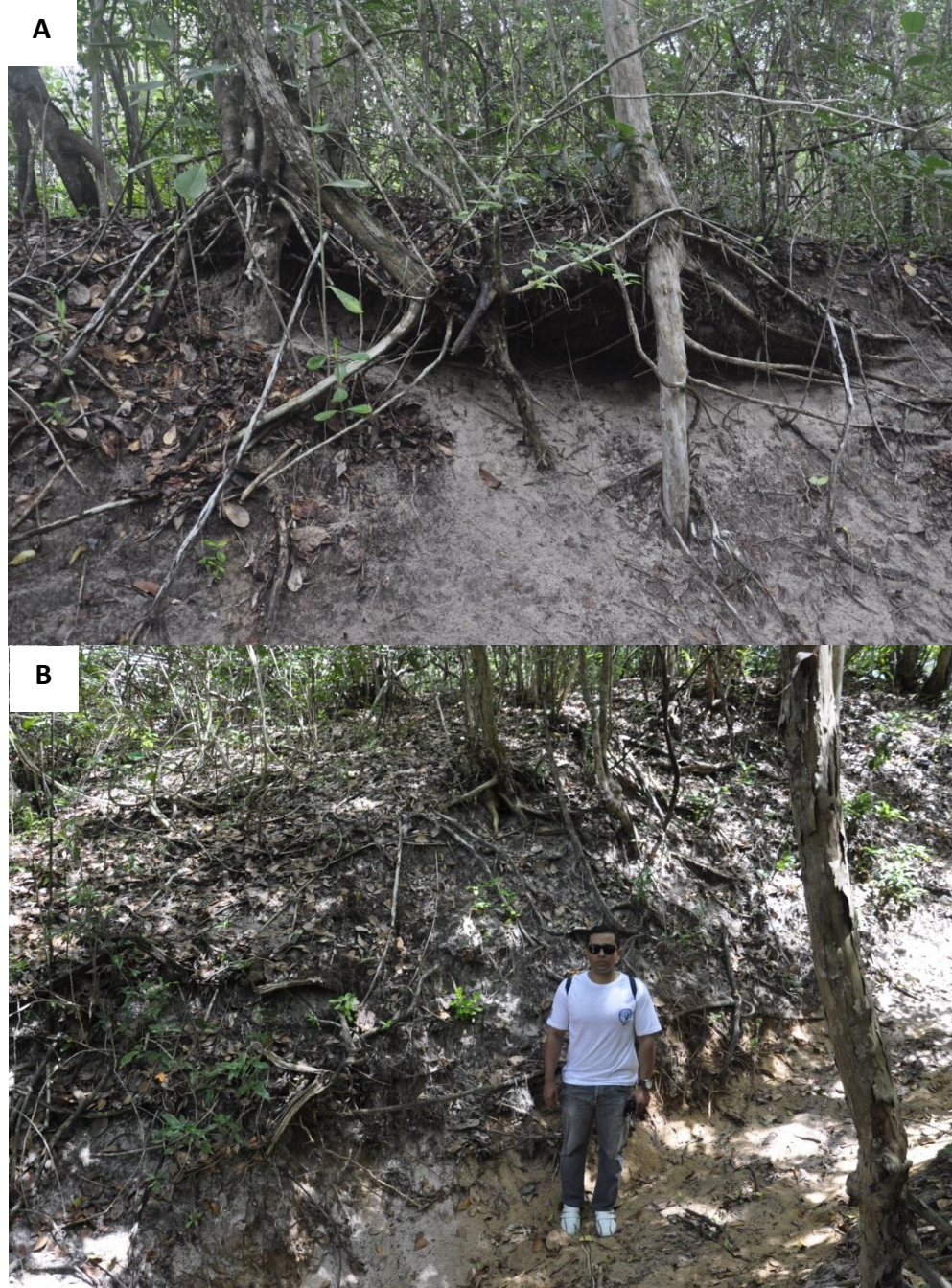
Figura 51. Trilha sobre dunas com avançado processo de erosão. Raízes da vegetação exposta.
