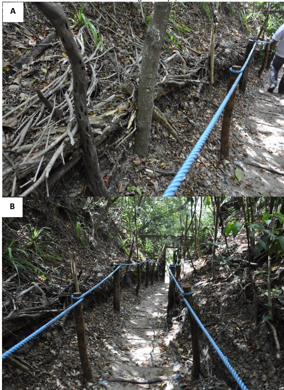
Figura 52. Modelo de contenção de processo erosivo utilizando materiais locais para construção de escada e corrimão. Santuário ecológico de Pipa, Tibau do Sul-RN.
