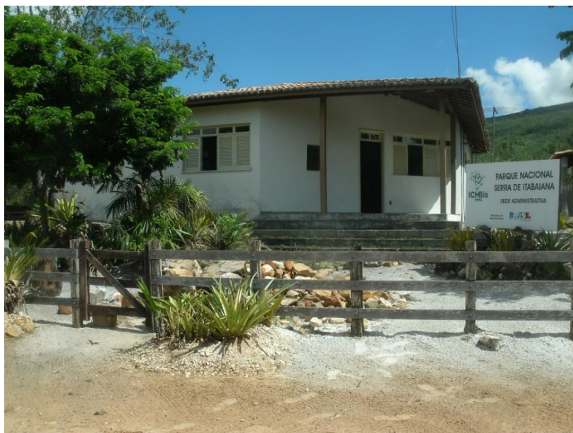
Figura 26: Casa onde funciona a Sede Administrativa do PNSI.
