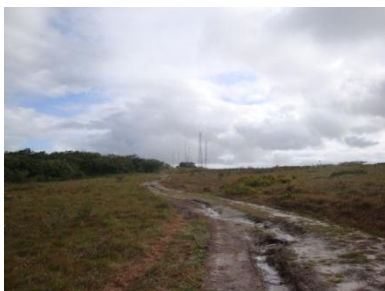
Figura 8: Estrada de Acesso ao topo da Serra de Itabaiana, com impactos à vegetação e erosão no leito principal. Ao fundo estão as torres.
