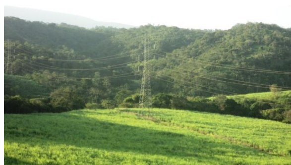
Figura 37: Torre de transmissão da CHESF, cortando áreas dentro do PNSI e seu entorno.
