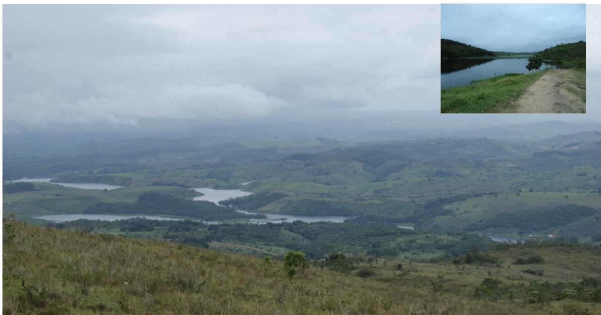
Figura 22: Barragem de Jacarecica II vista do topo da Serra de Itabaiana. No detalhe a direita, é a mesma Barragem, vista das suas margens (a vegetação à esquerda do lago é o PNSI, ao fundo é o Município de Malhador e à direita, Areia Branca).
