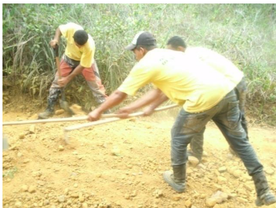
Figura 41: Outras atividades da Brigada do PNSI, como a manutenção de estradas, que também servem como aceiro.
